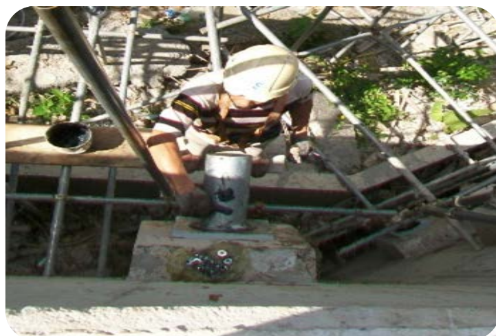
施作程序5B：可複拉地錨安裝保護蓋
