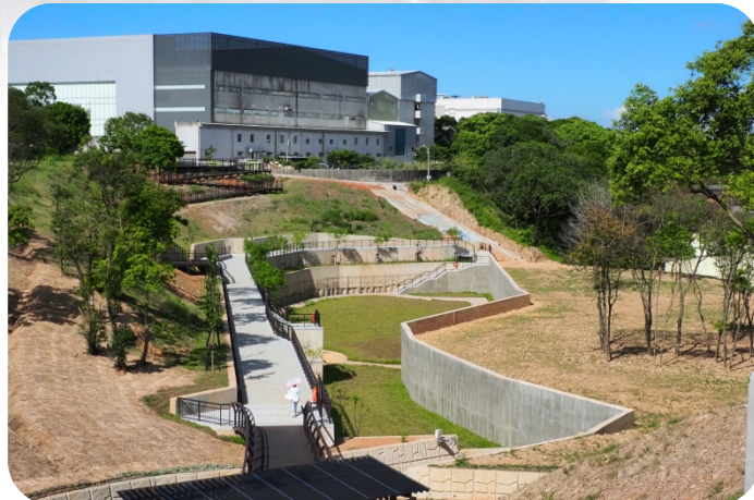
離槽式滯洪池
