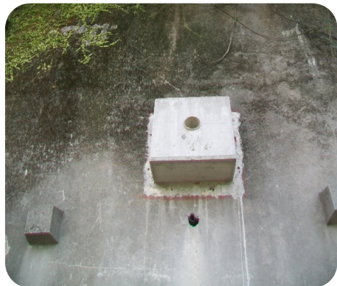
施作程序0：錨座施工
