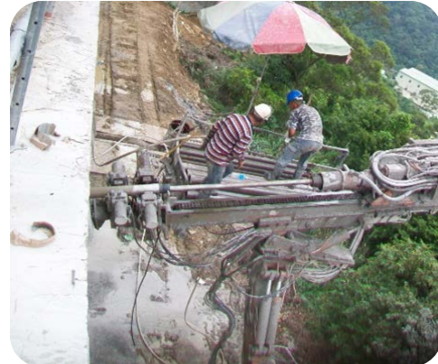
施作程序1B：可複拉地錨打孔
