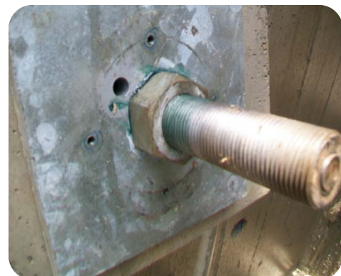
施作程序4C： 可複拉地錨施拉預力完成
