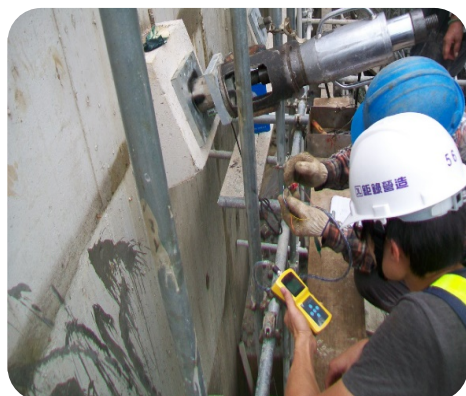
施作程序4A： 可複拉地錨施拉預力(含荷重計)
