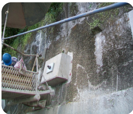
施作程序4B： 可複拉地錨施拉預力完成
