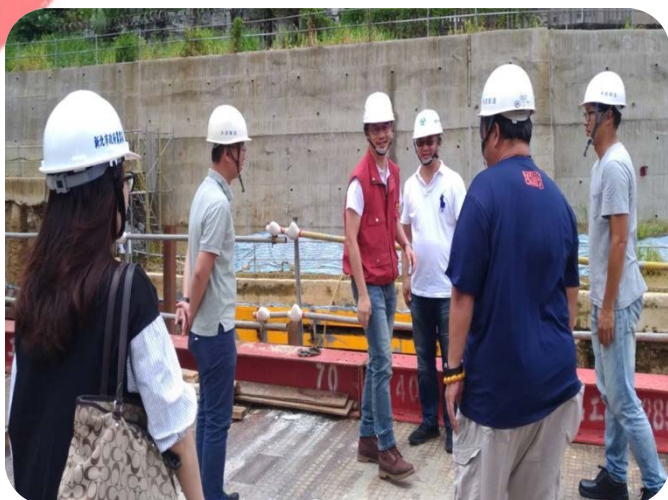
新北市政府農業局李玟局長視察水保計畫工地
