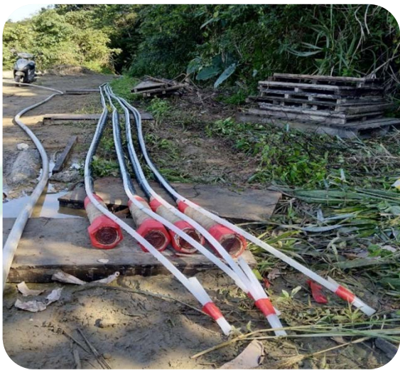
材料6B：可複拉地錨配上灌漿管
