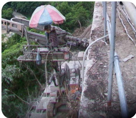
施作程序1A：可複拉地錨打孔
