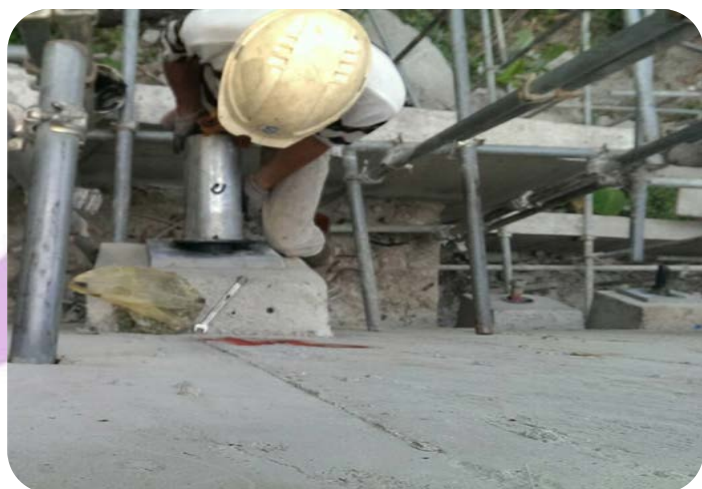
施作程序5A：可複拉地錨安裝保護蓋
