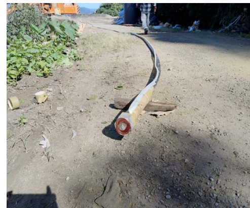
材料6A：可複拉地錨配上灌漿管
