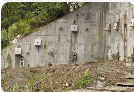
施作程序2C：可複拉地錨入鍵完成後
