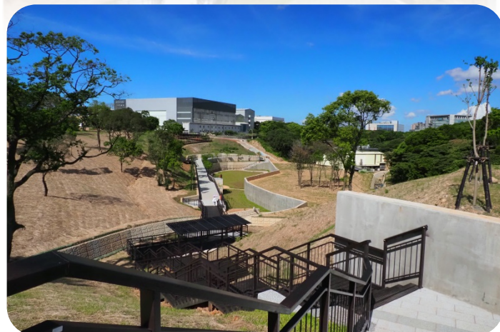
離槽式滯洪池
