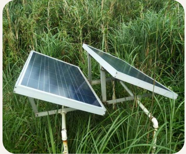
GNSS衛星導航系統太陽能供電系統
