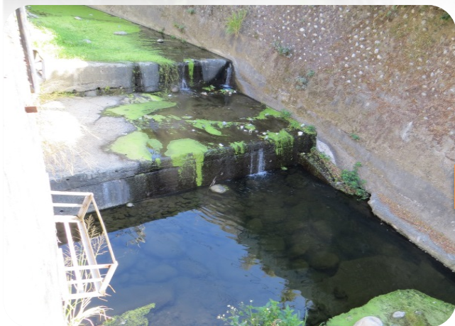
溪流復育前固床工現況
