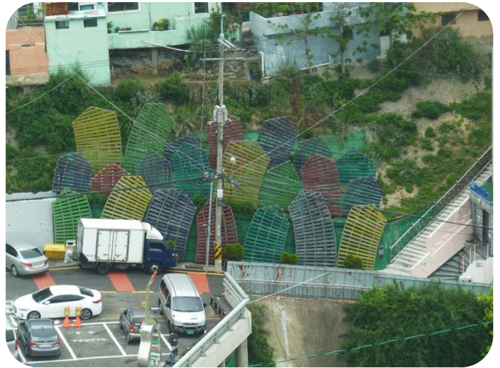
韓國釜山-山坡木構件(遠景)
