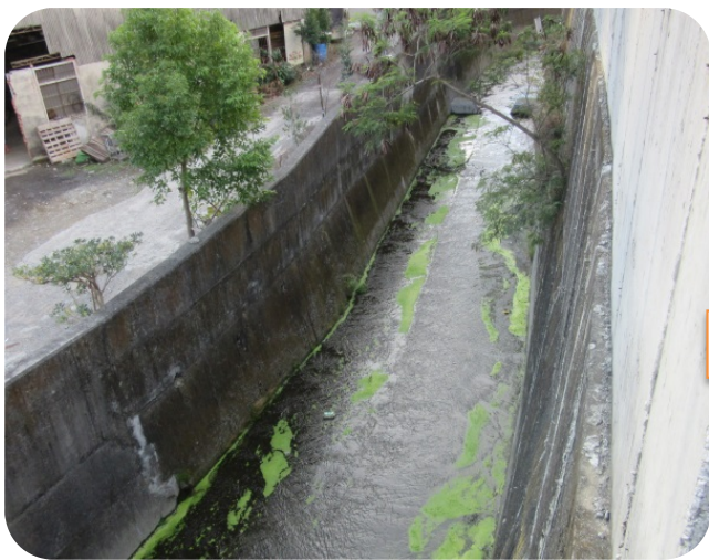
溪流復育前混凝土封底現況
