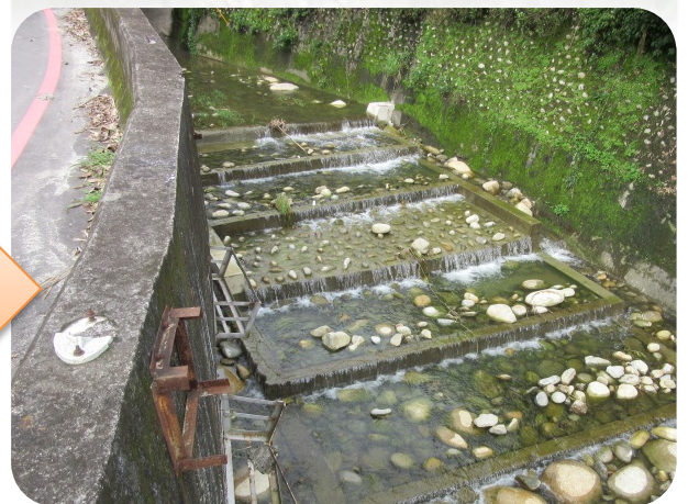
溪流復育後固床工現況
