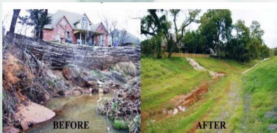
圖9: Coffee Creek溪流復育前後照片對照圖(2)。 (資料來源: National Engineering Handbook 654, Stream Restoration Design)
