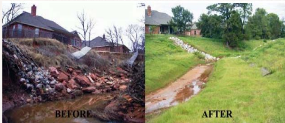
圖8: Coffee Creek溪流復育前後照片對照圖(1)。 (資料來源: National Engineering Handbook 654, Stream Restoration Design)
