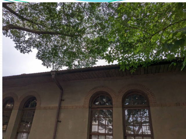
▲大院子的中央棟建築
