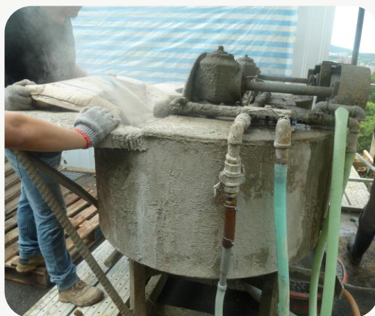
圖8 承壓型地錨施工流程--拌水泥漿
