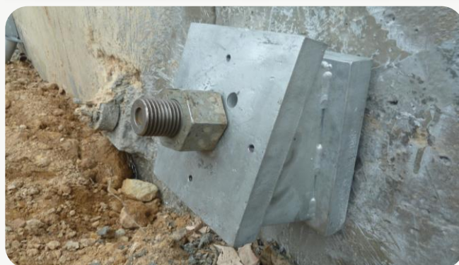
圖12 承壓型地錨施工流程--鎖定
