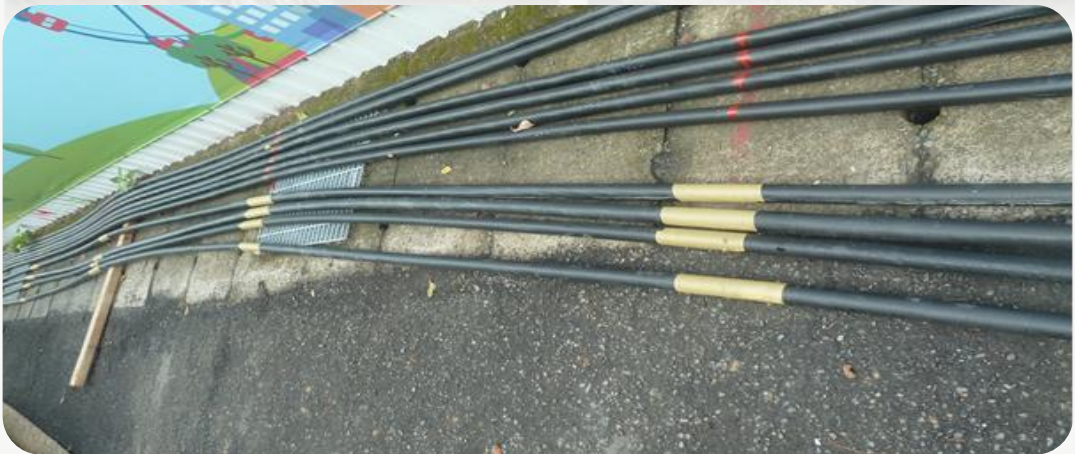
圖4 承壓型地錨構造圖(鋼鍵)
