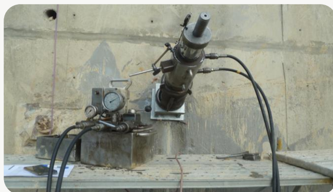
圖11 承壓型地錨施工流程--施拉預力
