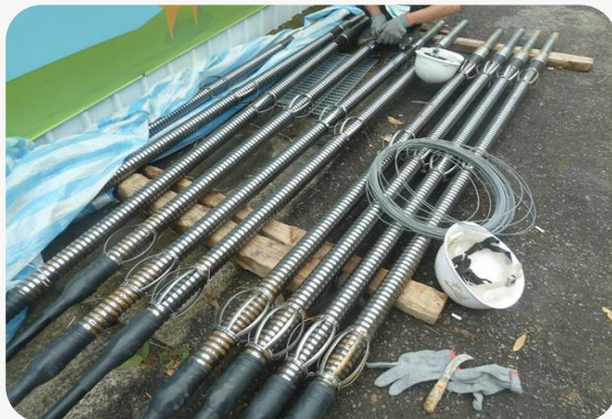
圖2 承壓型地錨構造圖(壓縮管)
