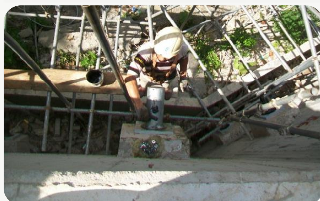
圖13 承壓型地錨施工流程--上保護蓋
