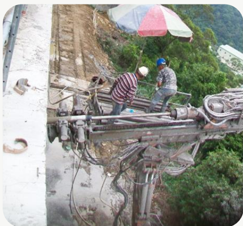
圖7承壓型地錨施工流程--打孔
