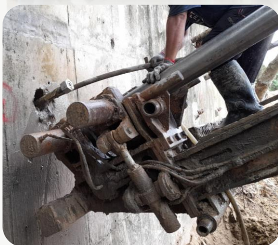
圖10承壓型地錨施工流程--補漿
