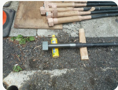
圖3 承壓型地錨構造圖(可調式錨頭)
