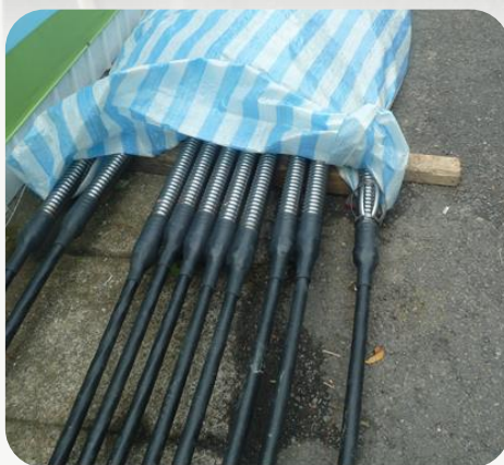
圖5 承壓型地錨構造圖 (壓縮管及鋼鍵)
