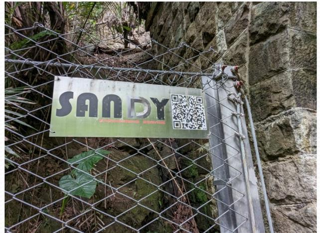
▲臺鐵宜蘭線猴硐舊隧道的防落石網
