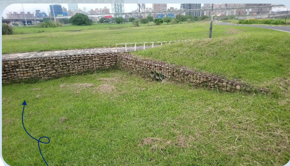
新北市三重區臺北大都會公園的入口堰石籠牆
