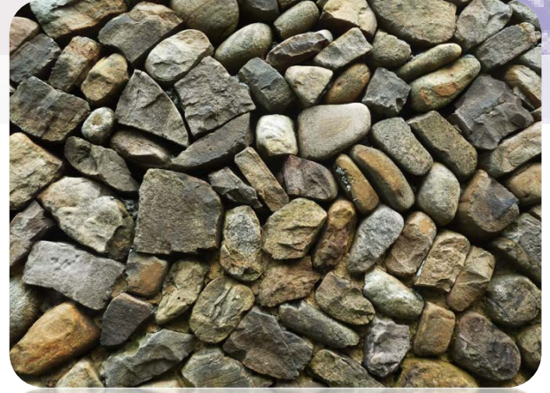
臺灣卯澳的近代砌石牆
