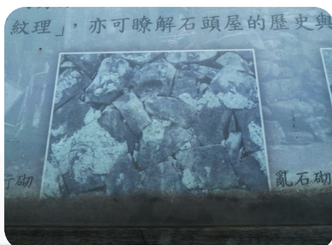
臺灣卯澳的砌石牆工法(亂石砌)
