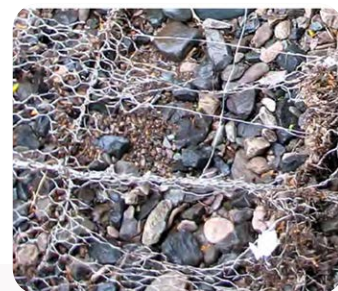
圖2 左圖:2006年底床箱籠毀損情形；右圖:2007年底床箱籠毀損情形
