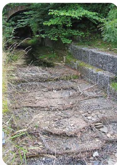
圖2 左圖:2006年底床箱籠毀損情形；右圖:2007年底床箱籠毀損情形
