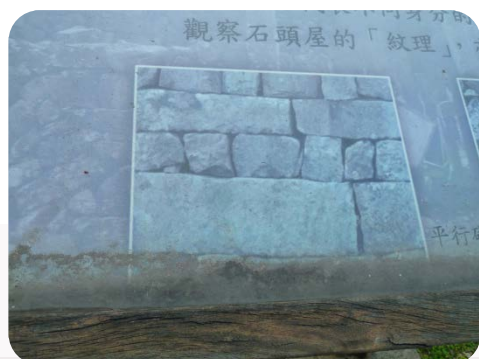
臺灣卯澳的砌石牆工法(水平砌)
