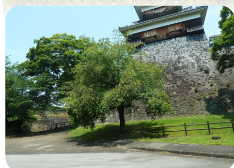
日本福岡熊本城的砌石牆
