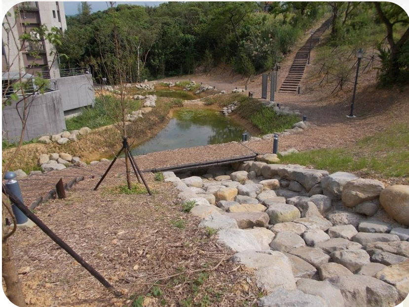
文山森林公園的生態滯洪沉砂池及生態排水設施
