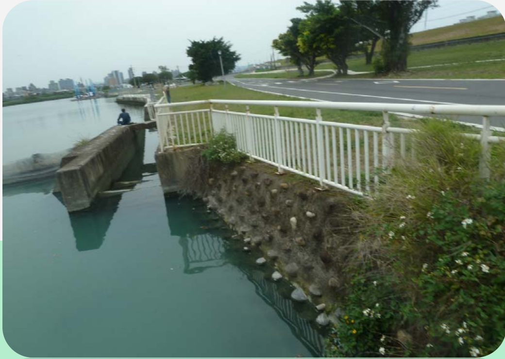
雙溪橡皮壩魚道入口
