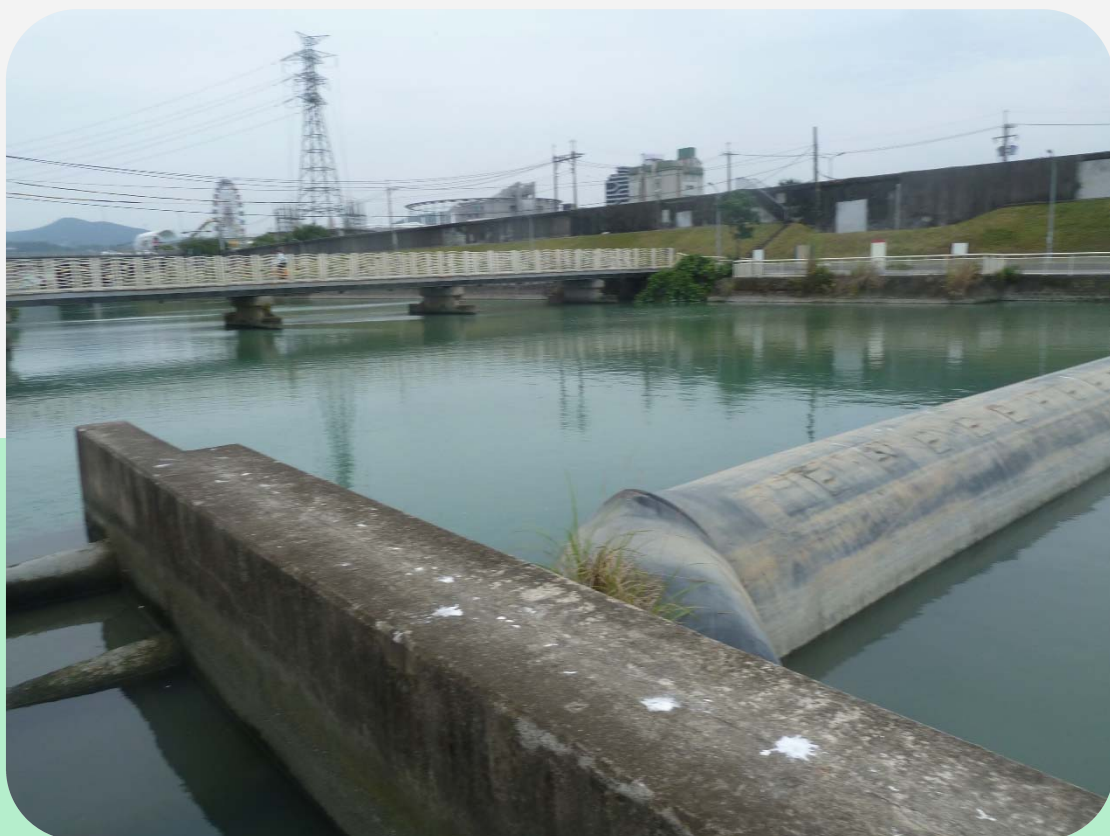
雙溪橡皮壩魚道及壩體，雙溪橡皮壩上方的便橋連接左、右岸，基隆河自行車道由此接回基隆河往關渡自行車道。
