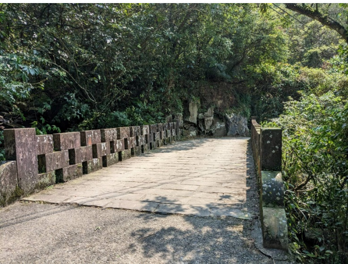
▲草嶺古道的跌死馬橋。
