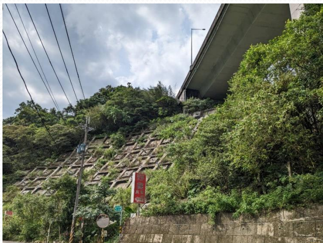
▲國道五號的重要地錨區
