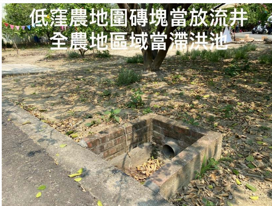
農民自主利用紅磚全區滯洪沉砂，以往水土保持的審視中可能質疑未符合水土保持技術規範第93條沉砂深度需求規定
