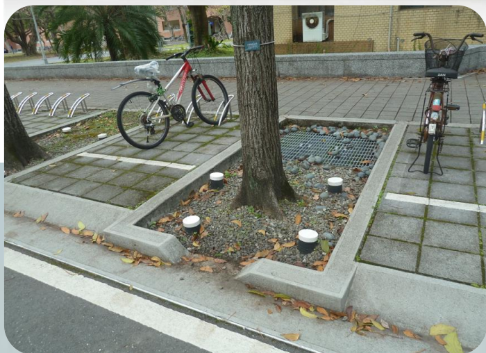
人行道透水鋪面設計，調節氣溫、涵養地下水源，也有助於減少積水面積
