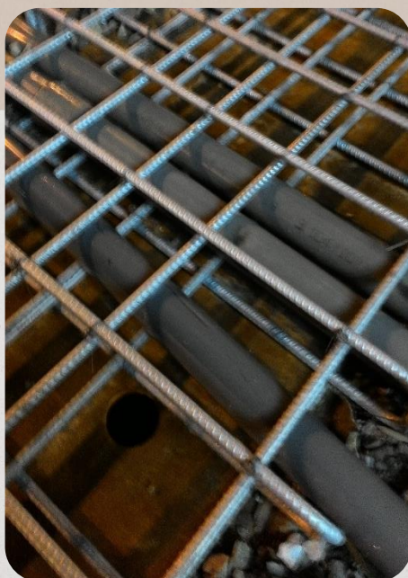
透水鋪面設計採用了防鏽鍍鋅鋼筋
