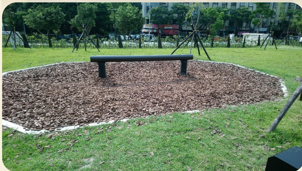
木屑表層入滲層鋪墊(表層鋪墊風倒樹循環再利用製成的木屑)
