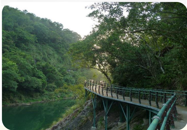
新北市 混凝土構件步道
