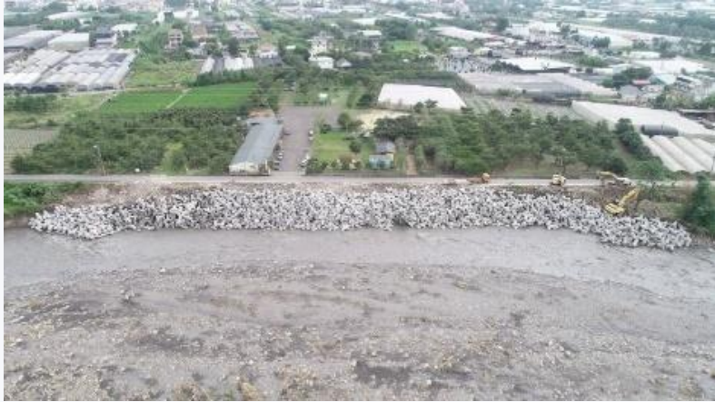
圖 6-2-10 108 年 0518 豪雨南投縣埔里鄉眉溪大湍二號堤防搶修工程 資料來源:經濟部水利署
