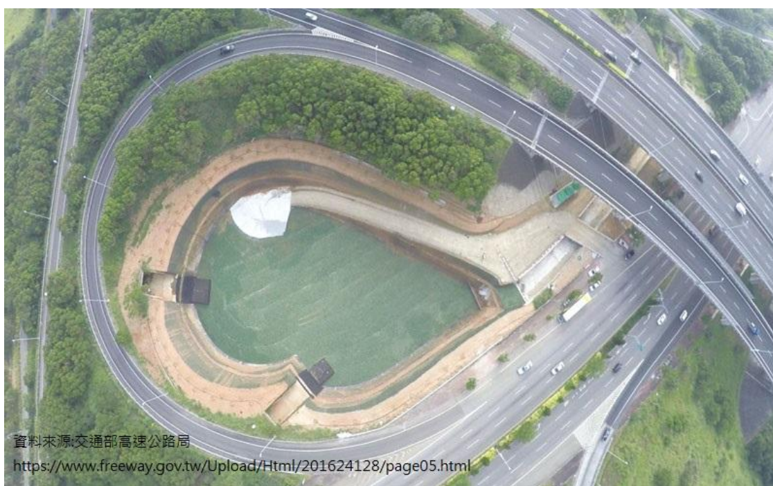
圖 4-3-5 沙鹿交流道增設滯洪池
