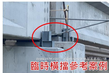
圖 6 帽梁外側設置臨時橫擋
