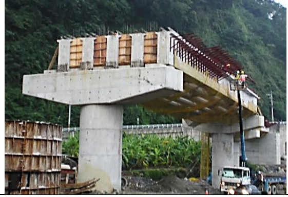
照片 10：預力梁吊放後隔梁施工中
