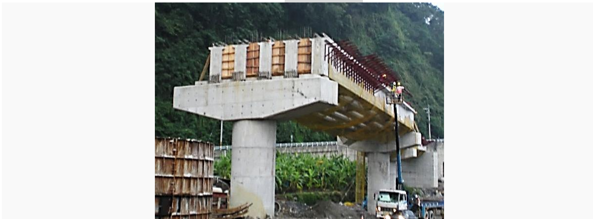
圖 11 端隔梁現場施工圖
