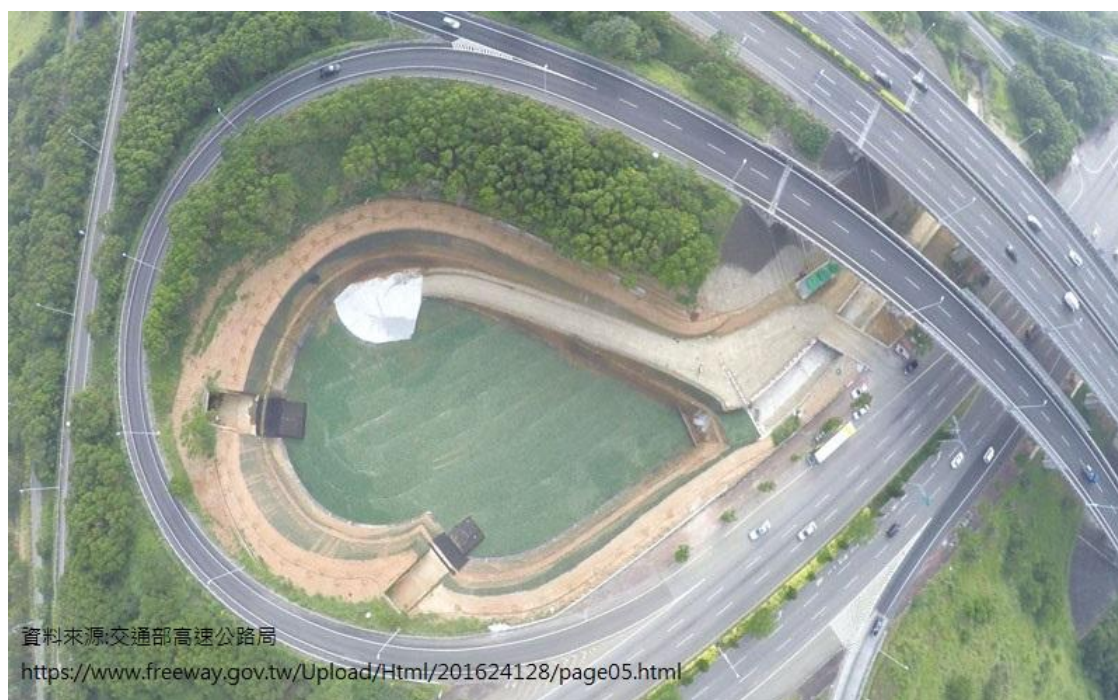
圖 4-3-5 沙鹿交流道增設滯洪池
