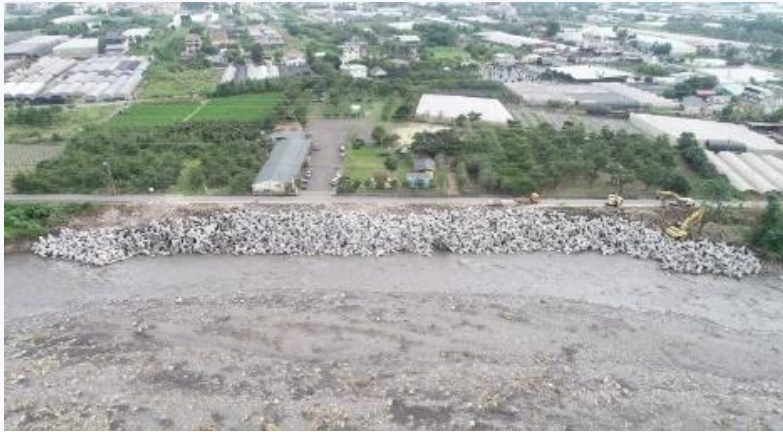
圖 6-2-10 108 年 0518 豪雨南投縣埔里鄉眉溪大湍二號堤防搶修工程
