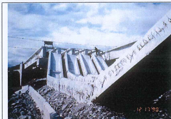
照片 3 79 年 12 月花蓮美崙溪橋
