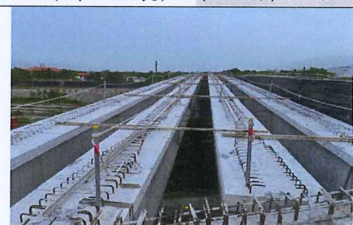
照片 8：吊放後-木料角材橫向連結
