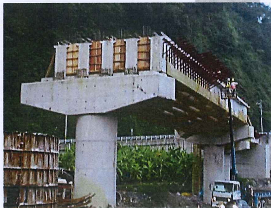
圖 8 端隔梁現場施工圖
