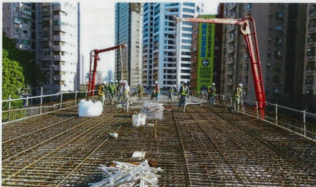
圖 9 橋面版穩固結構
