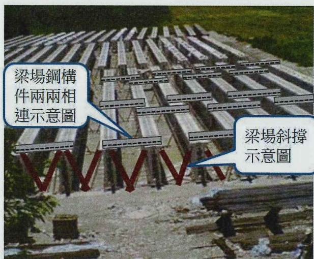
圖 6 梁場妥善固定預鑄預力 I 型梁
