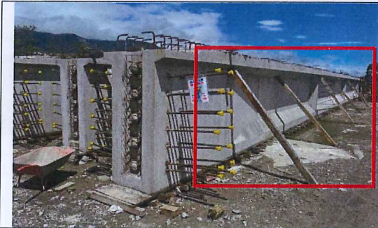
照片 5：吊放前-斜撐可均佈於梁身
