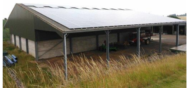
圖5 案例B 太陽能光電安裝在農業設施建築物屋頂
