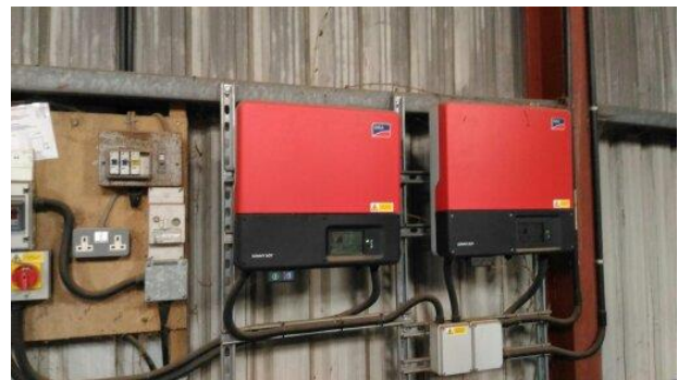
圖4 案例A 太陽能光電系統僅由簡單的電錶和開關控制
