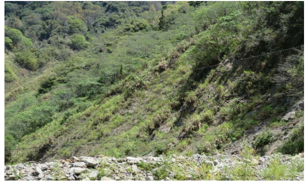
圖13 查核點④河道旁邊坡現況
