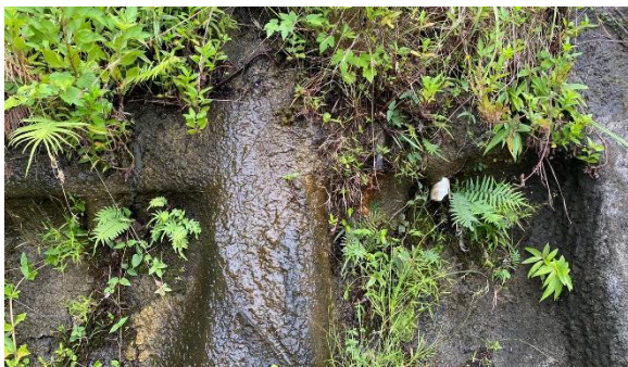
圖6 基地西側格柵護坡現況照片(近)
