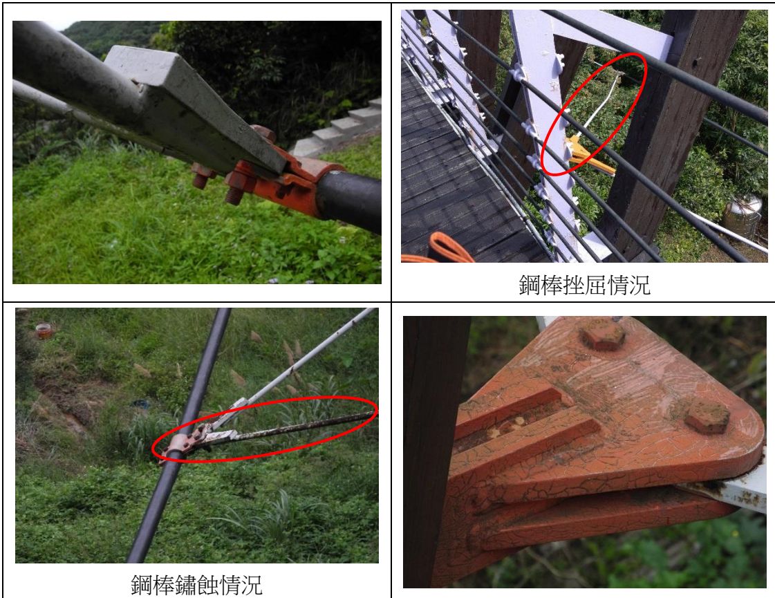
圖2-3 抗風鋼棒挫屈鏽蝕與接合情況
