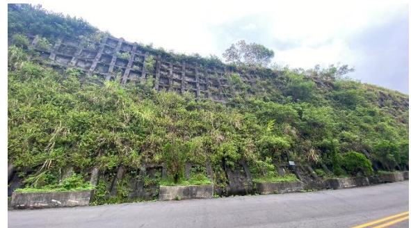
圖7 基地西側格柵護坡現況照片(遠)
