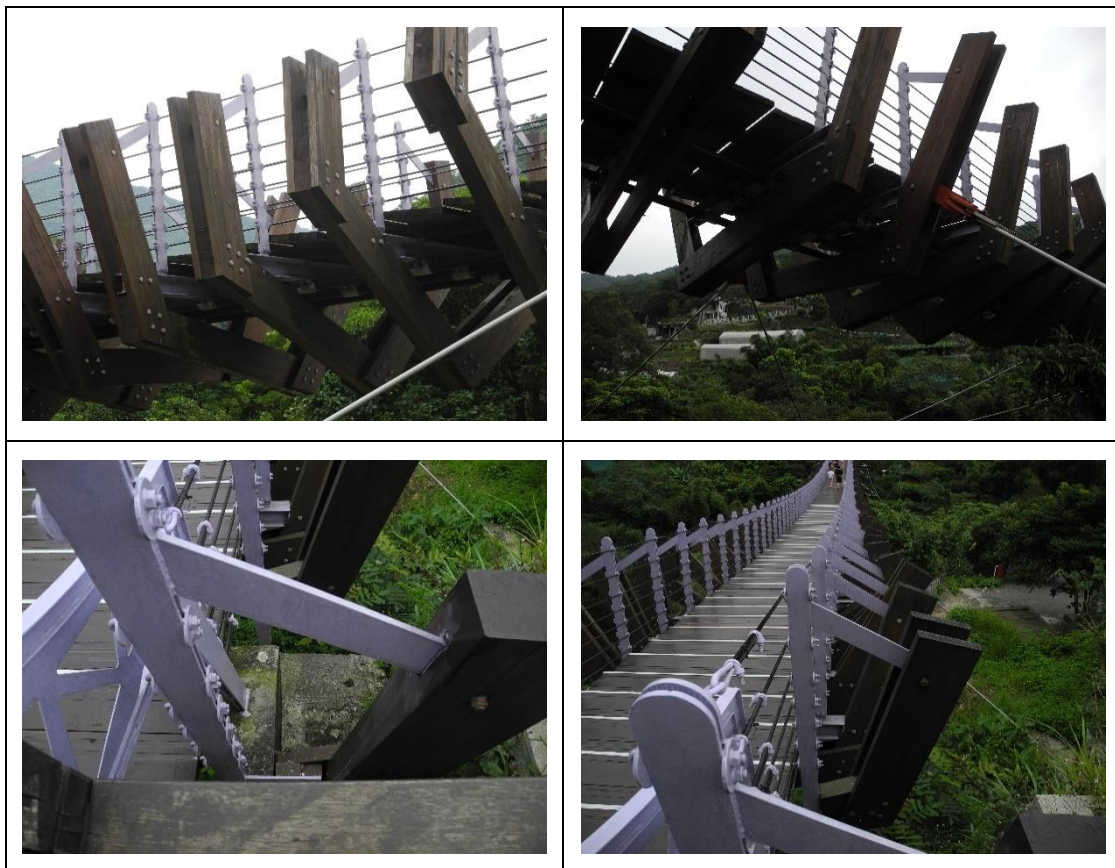
圖2-7 上部結構現場照片
