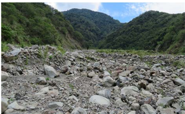
圖12 查核點③河道淤積大量土砂石塊
