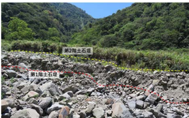
圖10 查核點①支流之沖積扇土石堤
