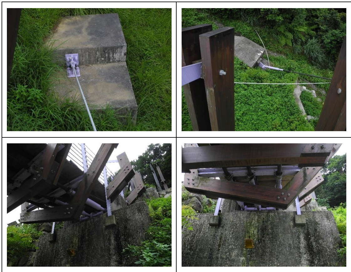
圖2-4 錨座基礎(左上為抗風鋼棒；右上為抗風索；下圖為主鋼索)
