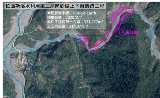
圖16 拉庫斯溪與荖濃溪匯流口至水利局防砂壩清疏工程示意圖
