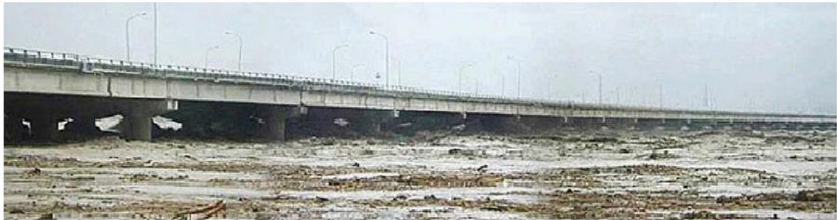
圖2 莫拉克風災時萬大大橋與洪流量與漂流木沖擊壅水情形
