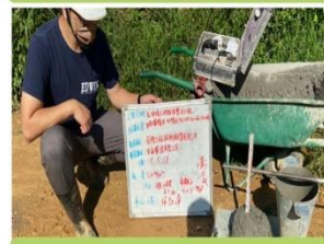
混凝土進場查驗
