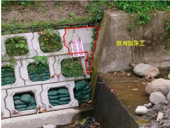
圖9 採用混凝土、碎石包等進行縫隙填補
