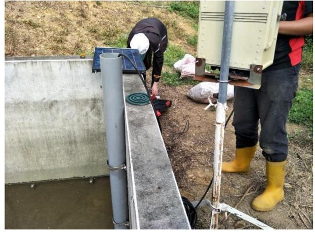
圖 5 壓力式水位計固定於 PVC 管內
