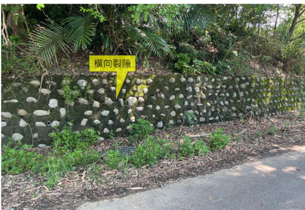
圖2 順向坡無開發風險案例-既有漿砌石擋土牆照片
