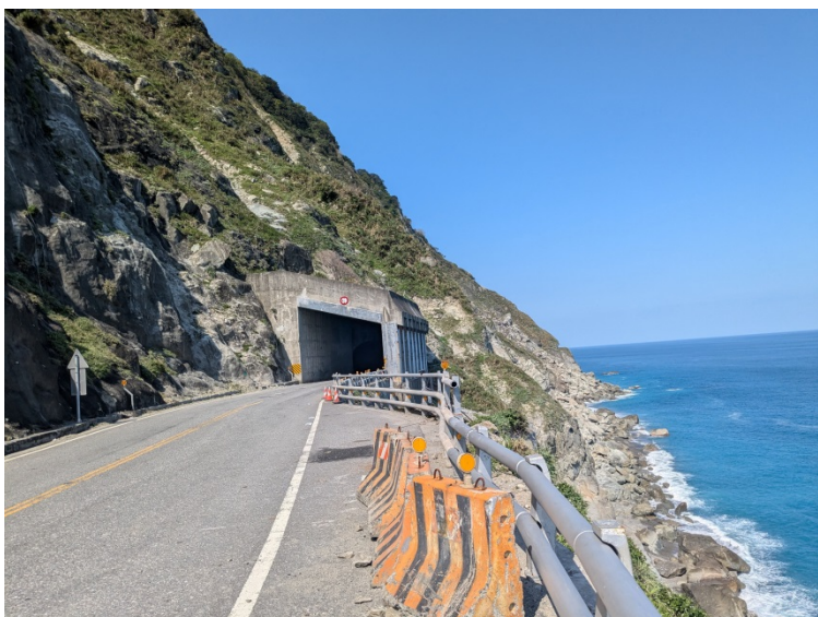
▲ 和平隧道 南入口
