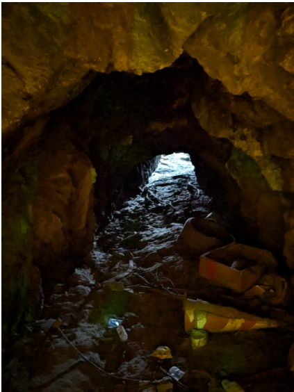
▲ 和平隧道 內的通風洞
