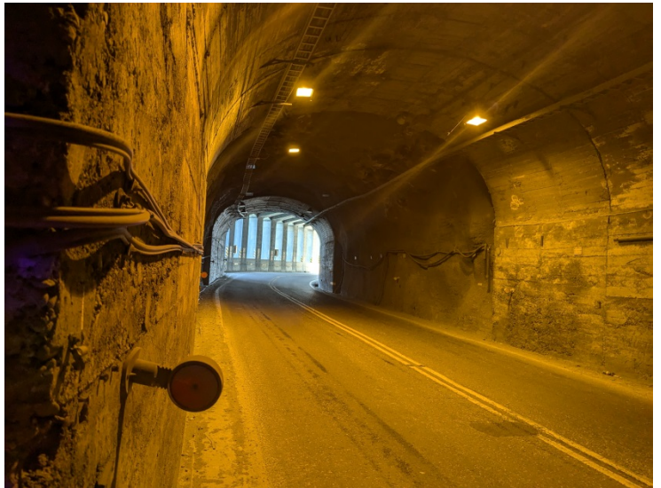
▲ 和平隧道 南入口前明隧道
